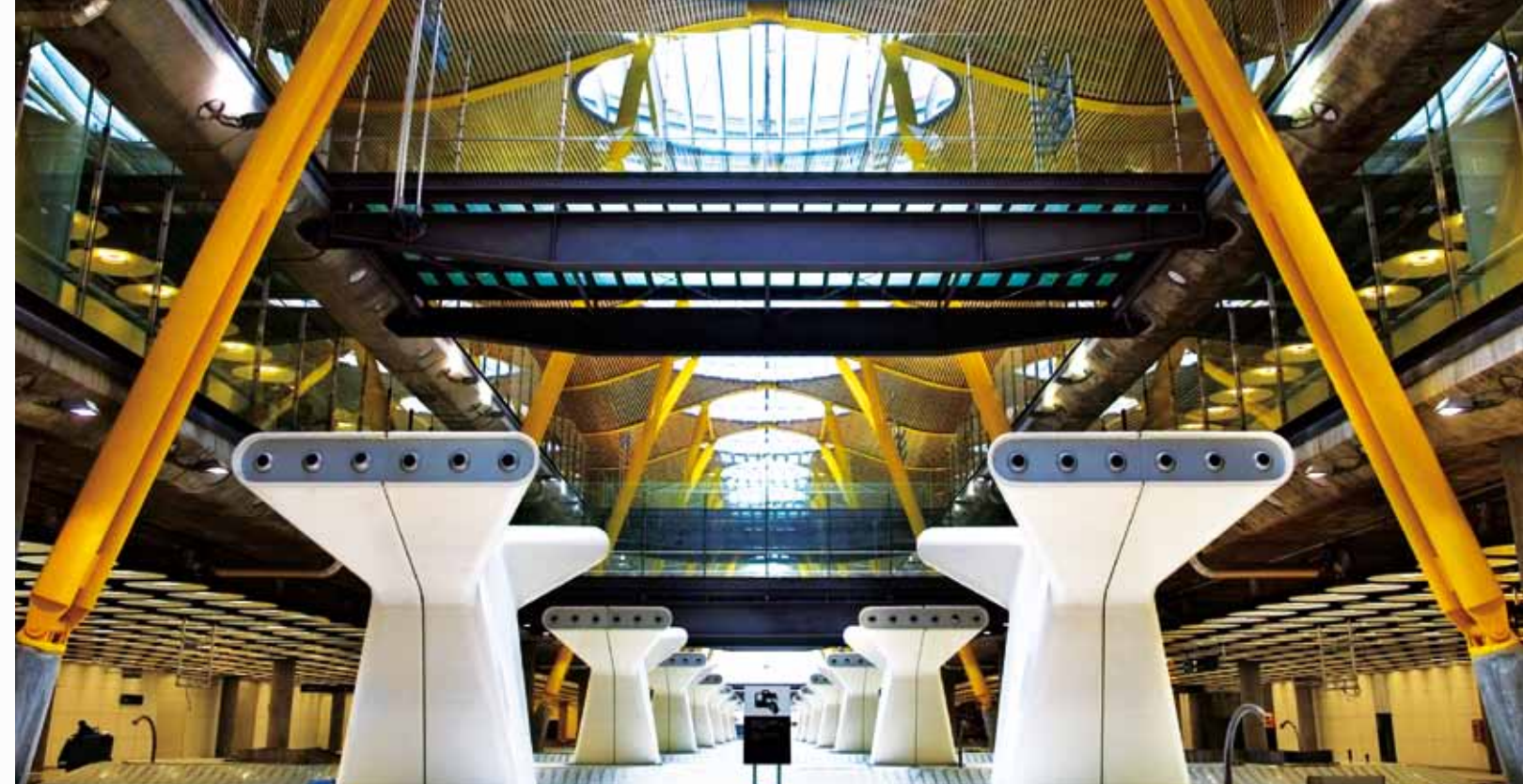
Integrierter Ansatz: Lüftungskomponenten, wie hier die TROX Weitwurfdüsen in der Gepäckabfertigung, sind integraler Bestandteil der Architektur.
