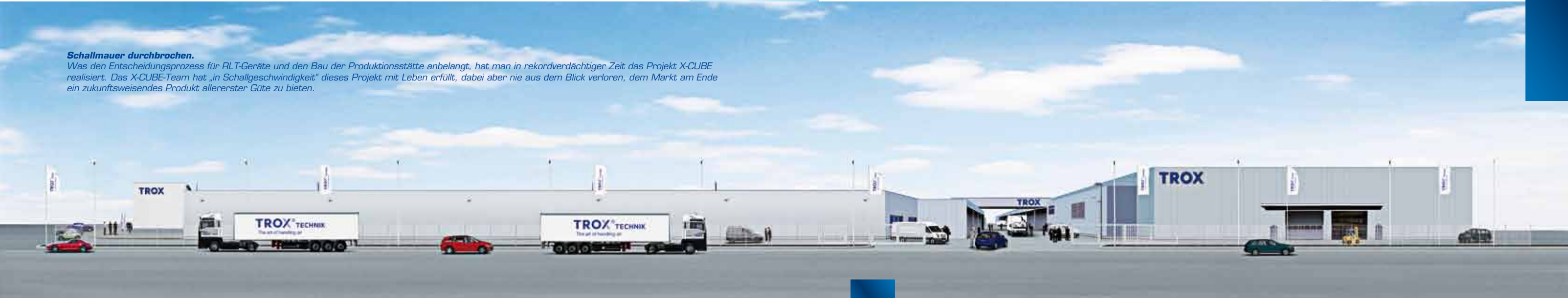
Das Werk in Anholt wurde durch die neue X-CUBE-Produktionsstätte – rechts im Bild – um 15.500 m 2 auf insgesamt 52.500 m 2 erweitert.
