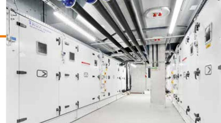
Das Haus M verfügt über 6 Lüftungszentralen, in denen 12 TROX X-CUBE arbeiten.
